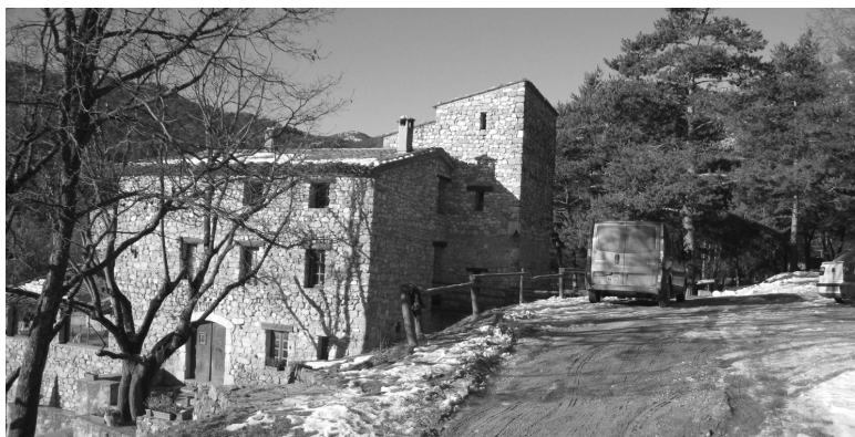
Vue côté Est où se construira l'extension du bâtiment
